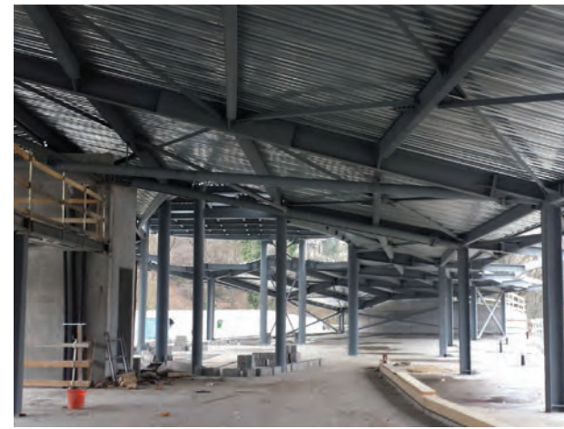
Vista delle strutture in acciaio in fase di cantiere.
